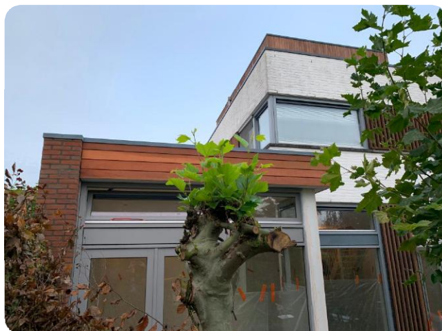
Foto achterzijde, het metselwerk moet nog wit gekeimd worden
