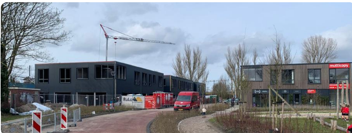
laatste fase bedrijfsunits in uitvoering
